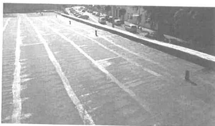
A Zöldfa u. 2-4. (Karát) üzlethelyiség új tetőszigeteléssel és bádoglemez-szegéllyel.
